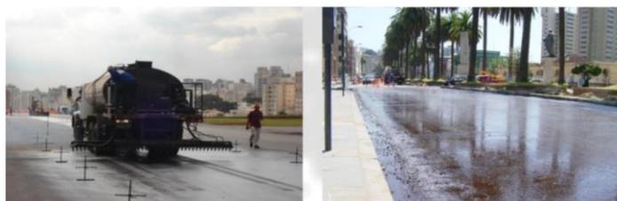
La emulsión debe ser aplicada y llevada a su ruptura (evaporación del solvente: lo que se verifica por el cambio de color de marrón a negro) antes de la aplicación del Geocompuesto HaTelit® y de la capa de concreto asfáltico subsecuente.
