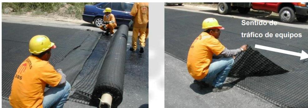
Se debe garantizar una longitud de anclaje mínima de 0,5 m a cada lado de las juntas o grietas puntuales a ser reforzadas por el Material . El Geotextil debe estar siempre hacia abajo.
