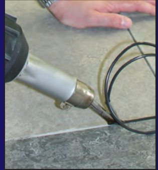
Revestimiento de suelos
