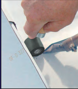
Fabricación de techos
