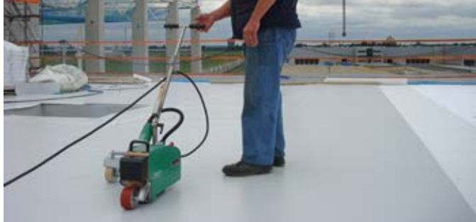
Guiado sencillo del equipo junto con una potencia de soldadura elevada.
