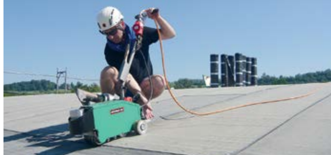
Soldadura de elastómeros sin llama con el BITUMAT B2.
