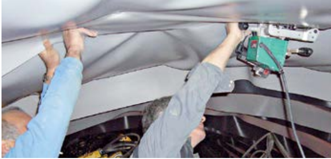
Trabajando con la COMET en un túnel ...
