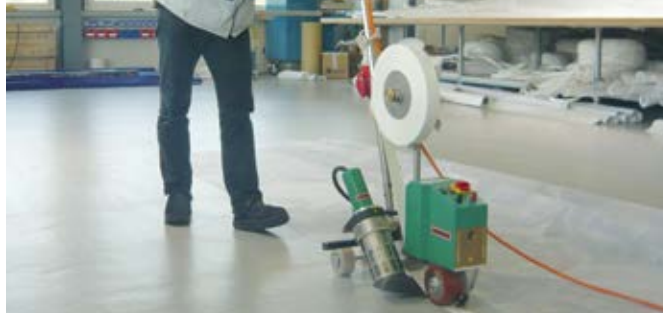
Soldadura de bandas a máxima velocidad.
