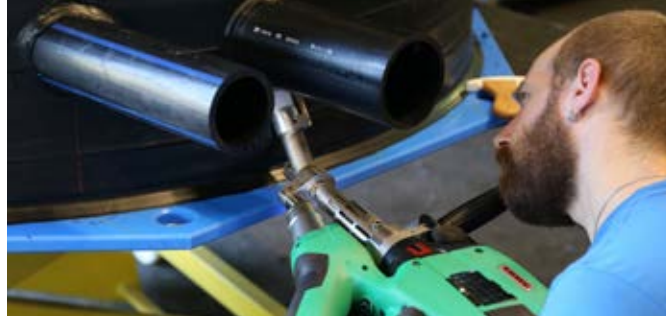
Las partes difíciles de llegar se sueldan con los nuevos adaptadores en ángulo de 45° y 90°.
