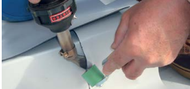
HOT JET S con tobera angulada en soldadura de una unión en T en un tejado.
