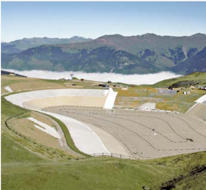
Reserva de agua HDPE 2.0 mm
