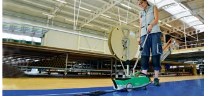
Soldadura rentable y ergonómica de las bandas de refuerzo.
